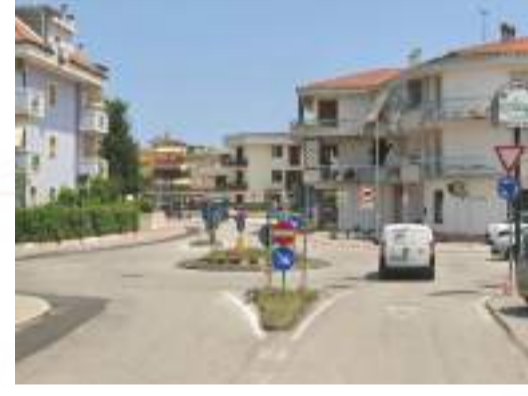
10 Incrocio Via Amendola, Via Circonvallazione Sud, Via dell'Industria e Via Benedetto Croce
