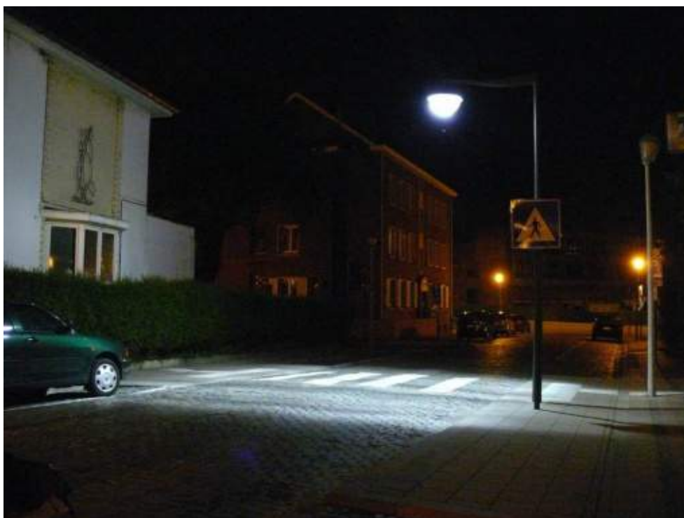
Figura 4-18 Illuminazione artificiale attraversamenti pedonali (Bruxelles 2010)
